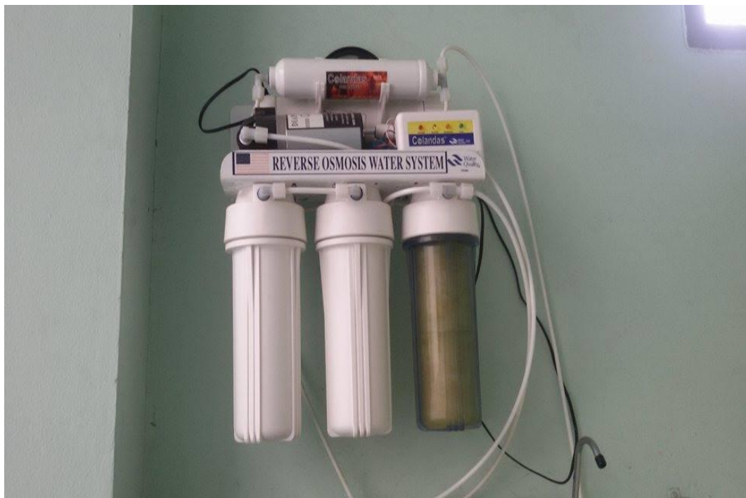
ภาพที่ จ-1 จุดเก็บน้ำรีโอสของพักอาจารย์สิ่งแวดล้อม
